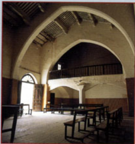
Interior de la sinagoga mayor de Híjar (s. XV).
